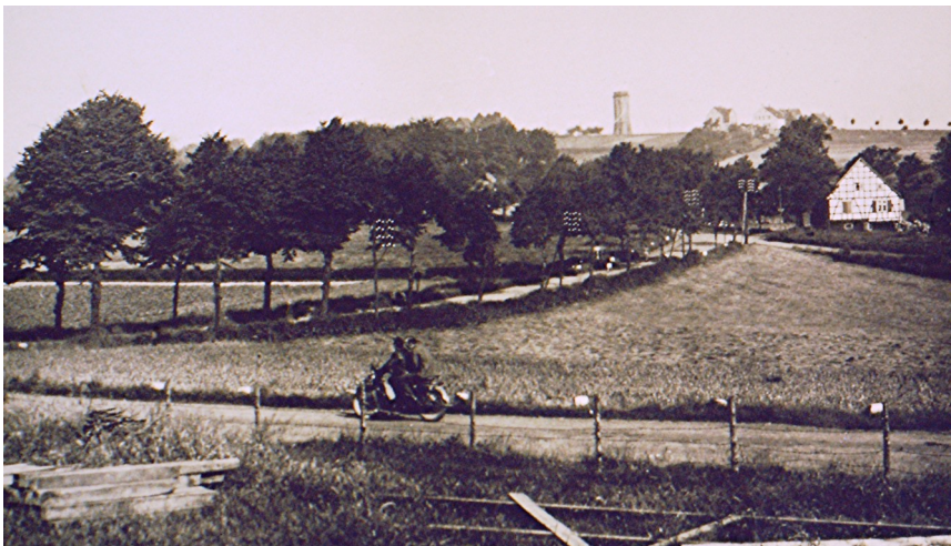
Wasserturm am Loh im Jahr 1932 (Blick von "An der Brille" Richtung Loh)
